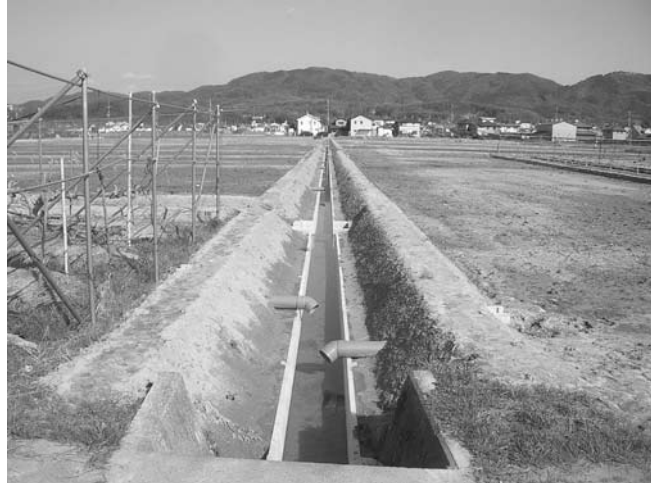
【下ノ段地区のは場整備】
