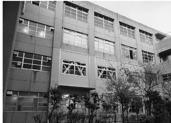
【耐震補強工事】
