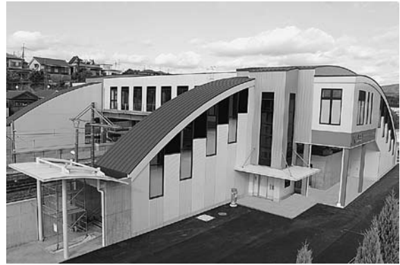
【長池駅自由通路・橋上駅舎】
